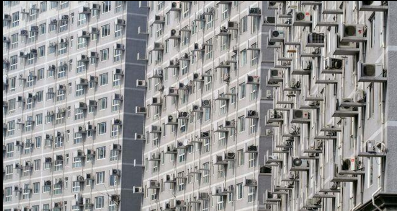
Un immeuble climatisé en Chine
